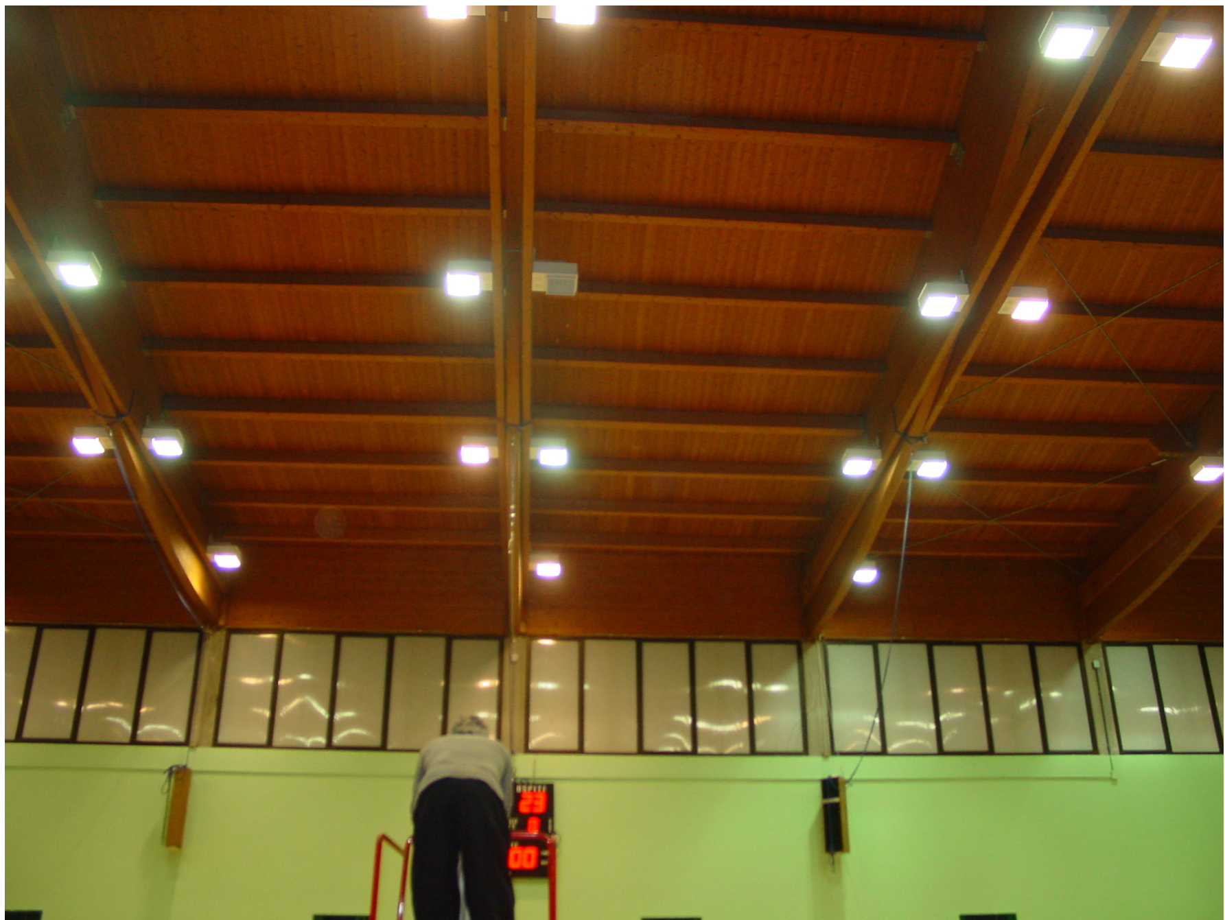
TAGLIO DI PO – Palazzetto dello sport vista interna n. 1
