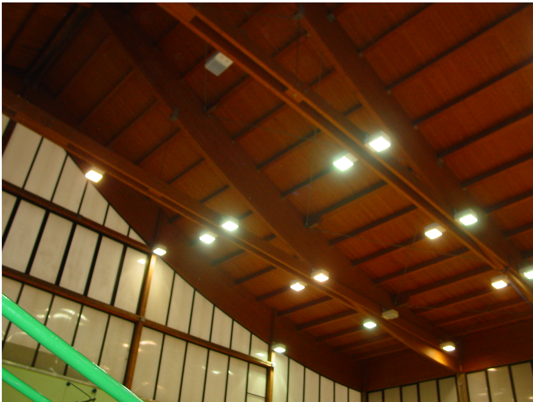
TAGLIO DI PO – Palazzetto dello sport vista interna n. 2
